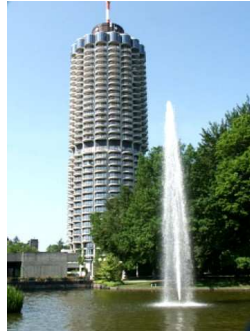
Kongreßhalle Augsburg Source: www.hotelturm-augsburg.de
